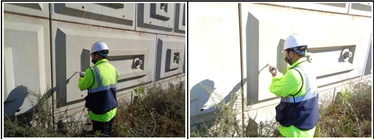
【그림 3.3.6】 슈미트해머를 이용한 반발경도시험 전경
